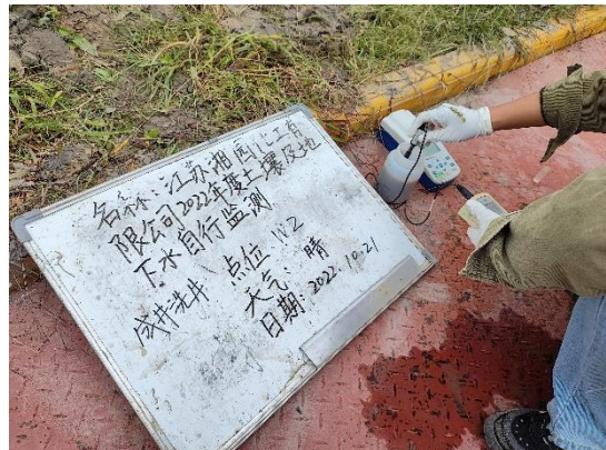
成井洗井出水现场检测
